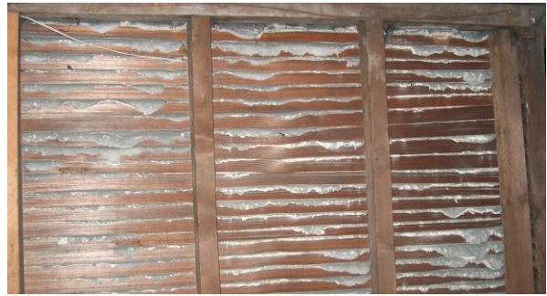
Binnenkant van een muur in vakwerk in het kasteel De Meidoorns te Gentbrugge, bouwjaar 1888. De plafondlatjes zijn in sparrenhout.
